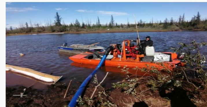
Откачка топливно-водяной смеси (Норильск 2020 г.)
