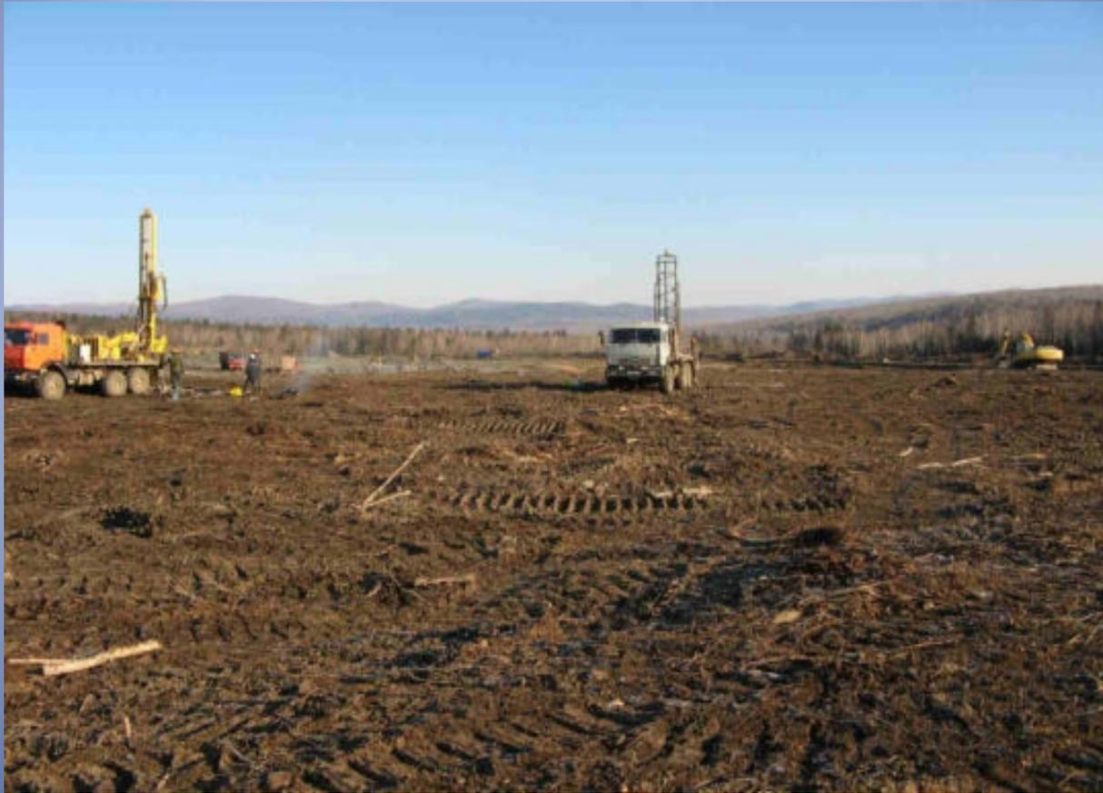
Бурение инженерно-геологических скважин на площадке главного корпуса проектируемой обогатительной фабрики
