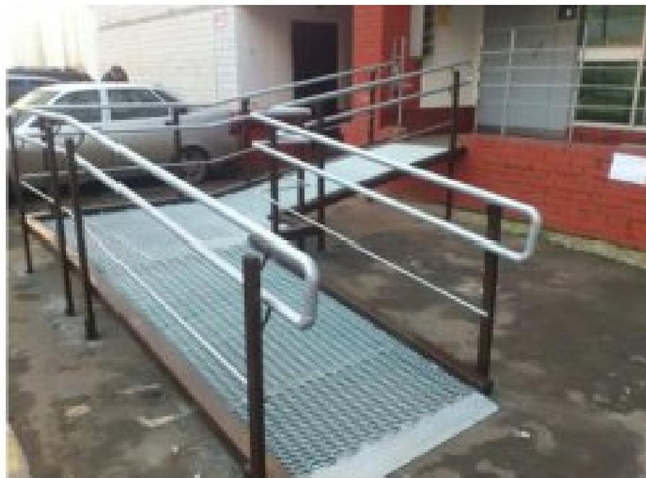
5.1.17 Ширина просветов их ячеек не должна превышать 0,013 м, а длина 0,015 м. Предпочтительно применение решеток с ромбовидными или квадратными ячейками. Диаметр круглых ячеек не должен превышать 0,018 м.
