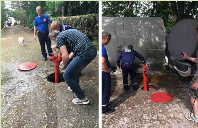
Май 2019г. Установка и проверка пожарных гидрантов.
